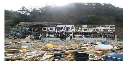
津波で損壊した寄磯漁港水産加工工場 (宮城県石巻市)
